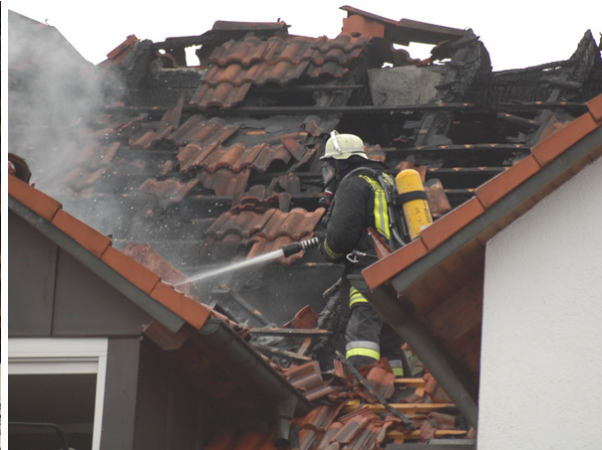
Nachlöscharbeiten am Dachstuhl
