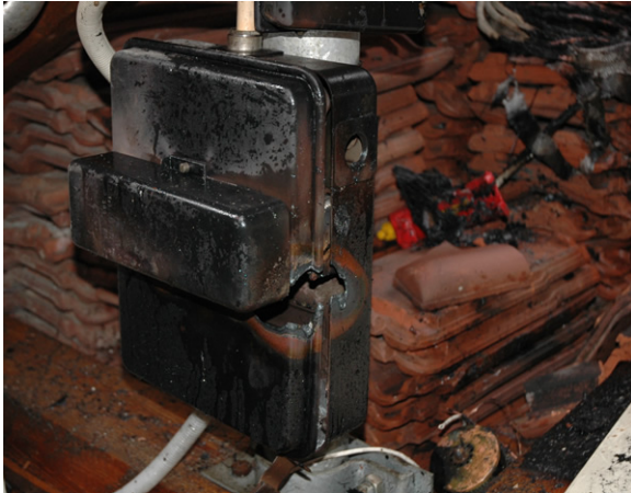
Hausanschlußkasten nach Blitzschlag
